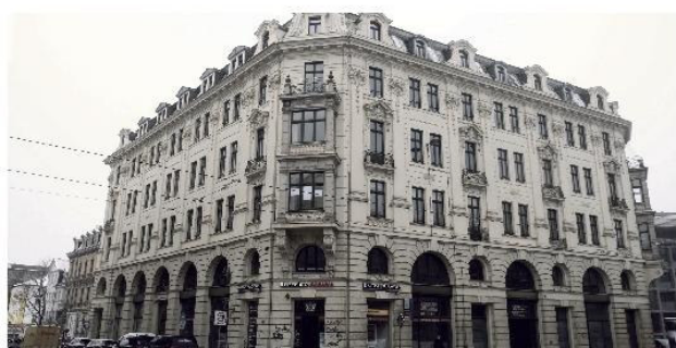
Das neue Willkommenszentrum in der Otto-Schill-Straße Foto: js
